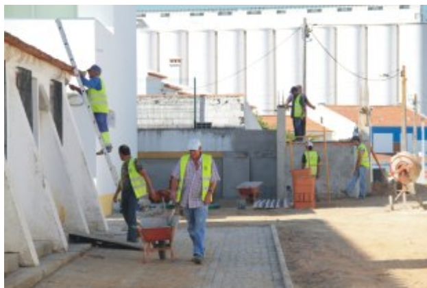
Construção de nova portaria
