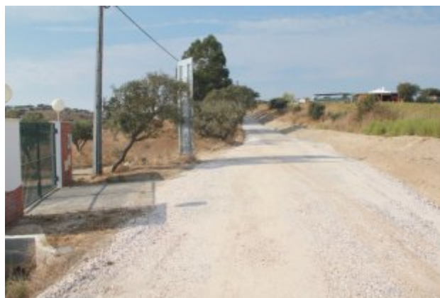
Conservação e manutenção de caminho agrícola - acesso à PITAR
