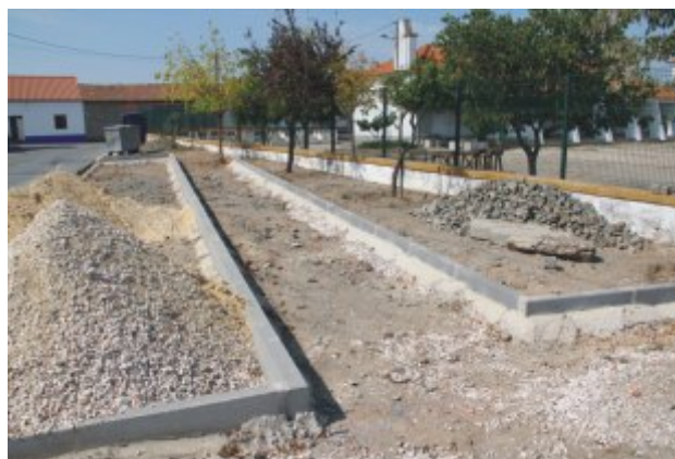
Construção de estacionamento e acessos pedonais na Avenida Dr. José Almeida
