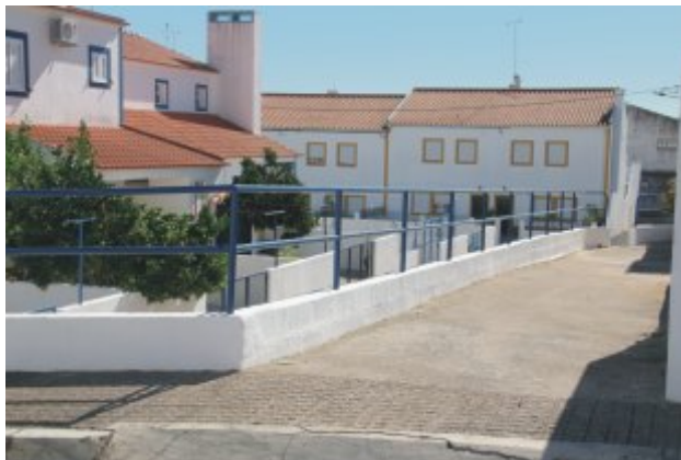
Colocação de gradeamento na Urbanização Habijovem - Zona Norte
