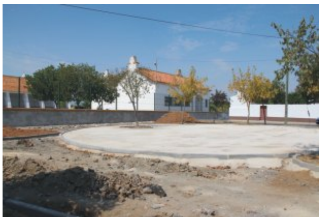
Construção de Parque Infantil no Parque da Junqueira
