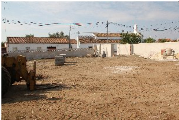
Construção de Parque Infantil e Desportivo
