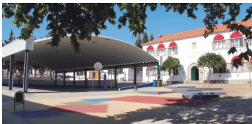
Cobertura do Campo de Jogos e arranjos exteriores
