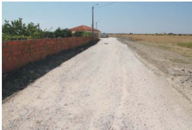
Construção de caminho
