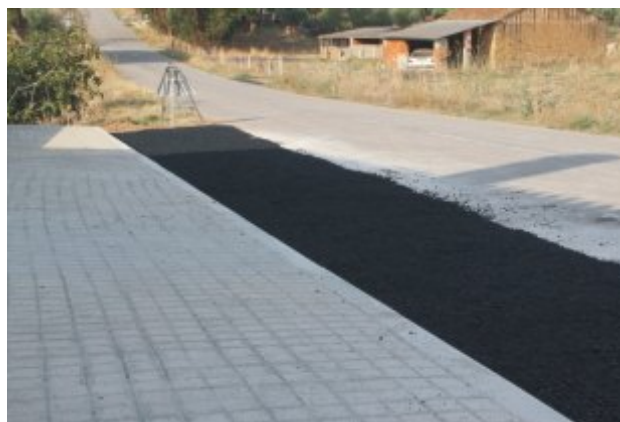
Construção de Passeios
