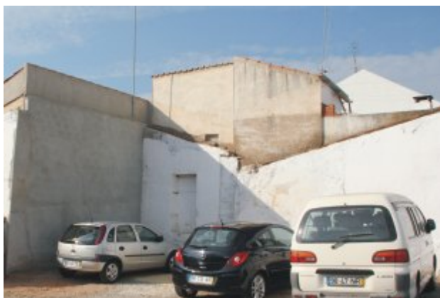
Demolição de edifício para futura Unidade de Saúde e consolidação estrutural dos edifícios adjacentes
