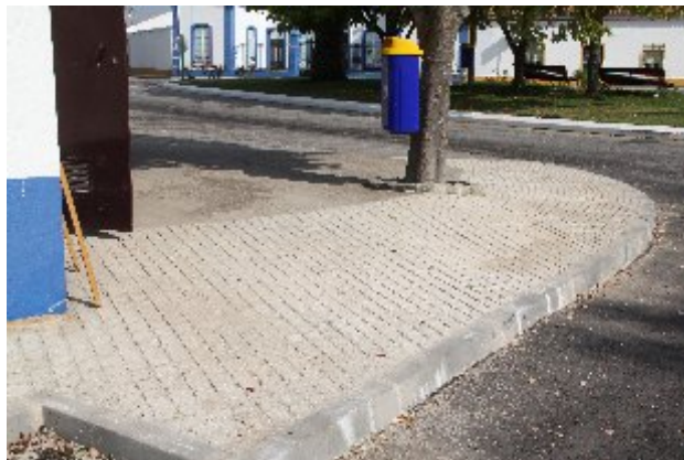
Construção de Passeios e outras obras de manutenção
