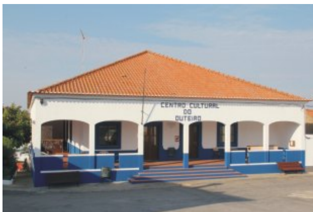
Pintura do Edifício do Centro Cultural de Outeiro
