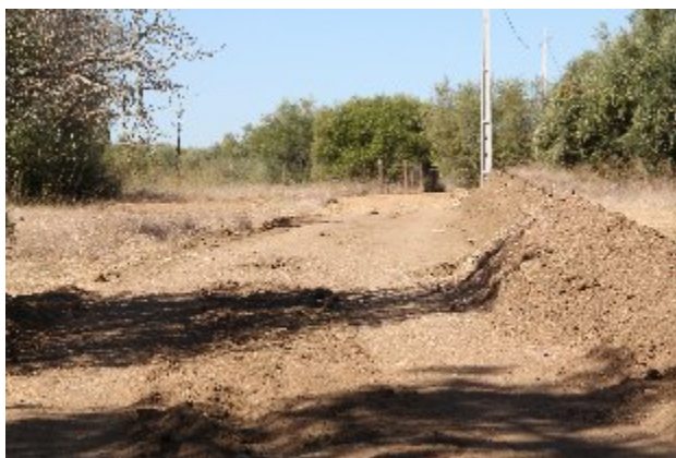
Conservação e manutenção de caminho agrícola - Monte de Santa Catarina
