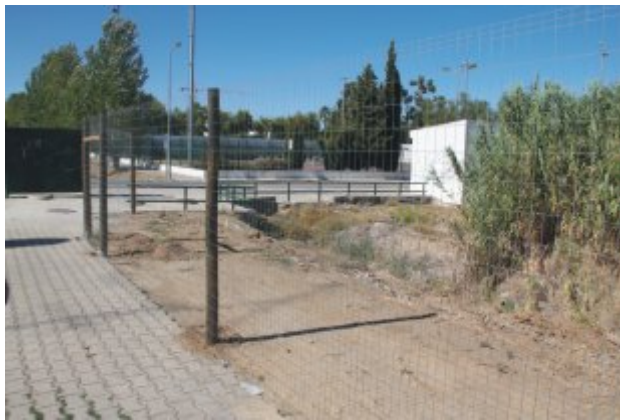
Colocação de vedação de segurança junto à Escola Básica n.º 1
