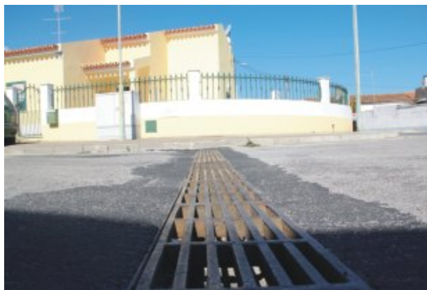
Substituição de Canaleta na Rua Dr. Jacinto Fernandes Palma
