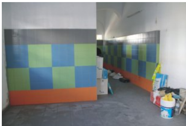
Requalificação dos sanitários do Bloco A
