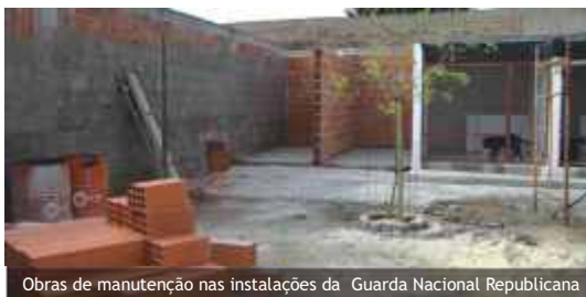
Obras de manutenção nas instalações da Guarda Nacional Republicana
