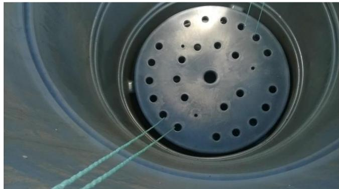
**Foto 8 – Instalação do escorredor de lixiviados nos contentores “molok”**
