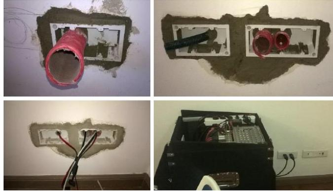
*No decorrer da obra de decoração do Salão Nobre da Câmara Municipal foi instalada uma infraestrutura de cablagem, embutida nas paredes, que permite a utilização de sistemas multimédia nos topos do espaço físico do salão. Desta forma Pcs, mesas misturadoras ou outro equipamento podem ser colocados e operados nas extremidades da sala. Foram instalados cabos VGA, HDMI, e som.*
