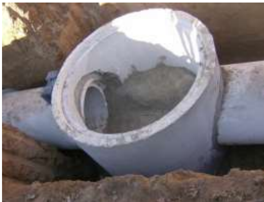
Ligação de caixa de visita com a rede de águas pluviais DN1000
