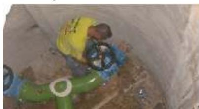
*Substituição das Válvulas da Conduto de Saída do Reservatório do Moinho de Vento*
