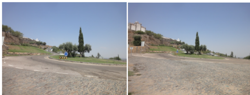
Fotos 1 e 2 - prédio a avaliar (já ocupado)
